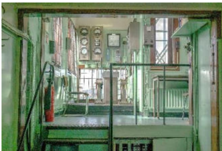
Bedieningsruimte van de brug **
